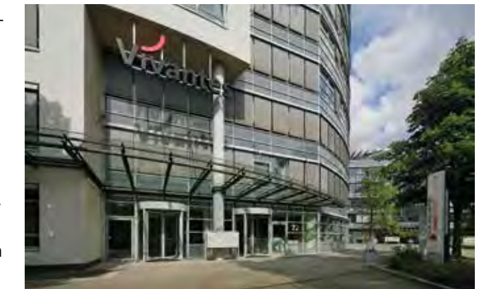
Seit Ende 2012 Sitz der Verwaltung: Ein modernes Bürogebäude an der Arosier Allee in Berlin-Reinickendorf.
